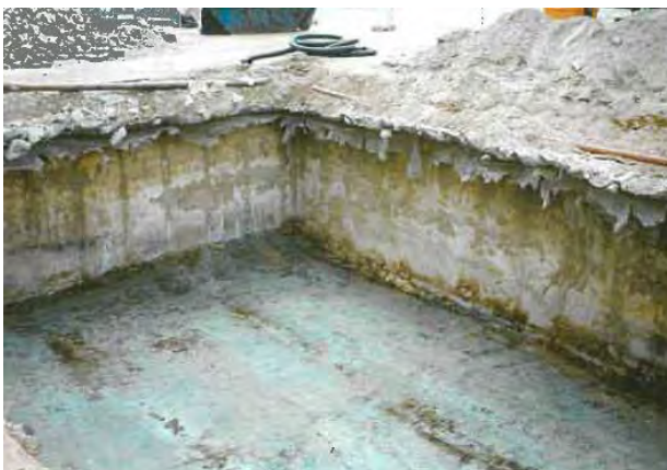
Bild 01: Ansicht Betonwanne nach Ausbau der unterirdischen Kraftstofftanks und Aushub/Sanierung der verunreinigten Böden (Datum ca. Anfang 08/1999, Blickrichtung unbekannt).
